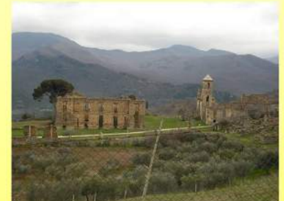
Fig. 8 – Campomaggiore vecchio oggi. Si può notare la forte inclinazione delle pareti dei monumenti del paese vecchio verso monte.
