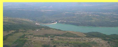
Fig. 11– Panoramica della Diga del Pertusillo, situata al confine tra i comuni di Grumento Nova, Montemurro e Spinoso.
